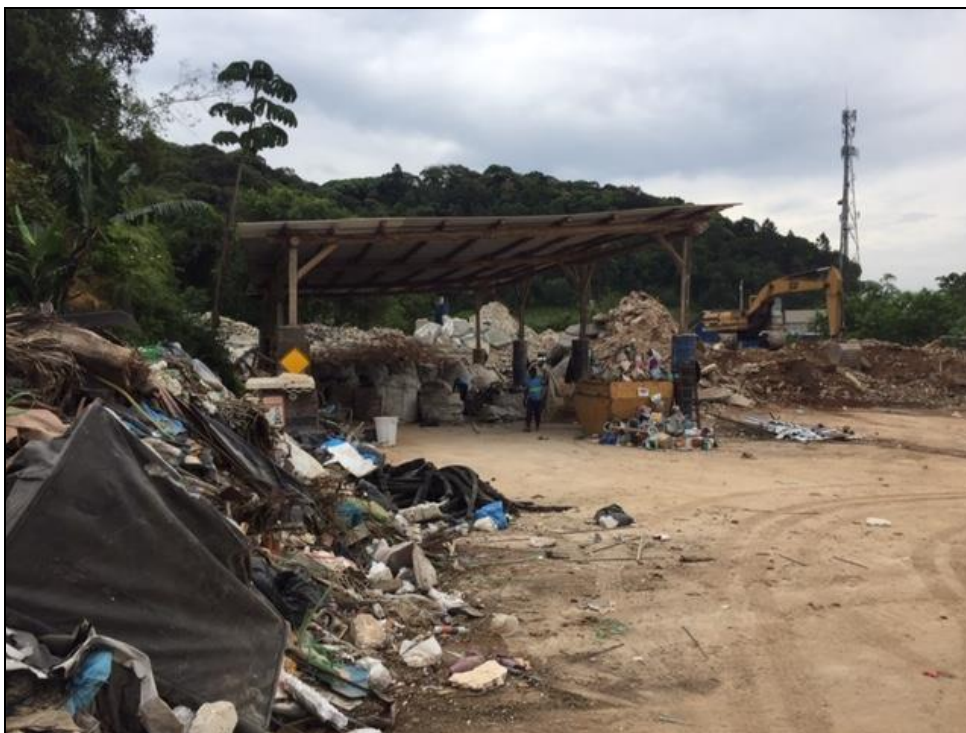
Figura 43 – Área de reciclagem de resíduos da construção civil da Empresa Terraplanagem Medeiros Fonte: Premier Engenharia, 2019.
