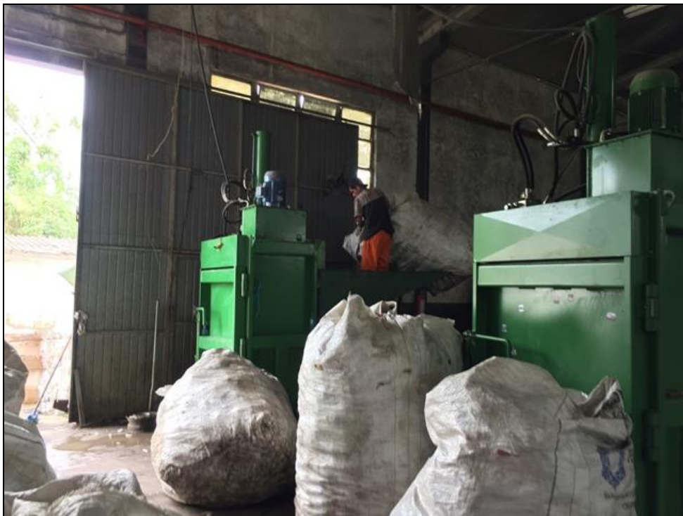
Figura 72 – Unidade de Reciclagem da RECICLA (prensas) Fonte: Premier Engenharia, 2019.
