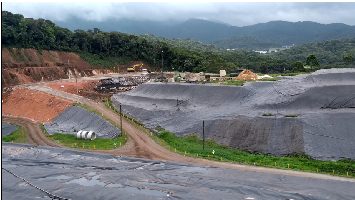
Figura 54 – Célula de disposição de resíduos classe I (aterro industrial da Essencis)
