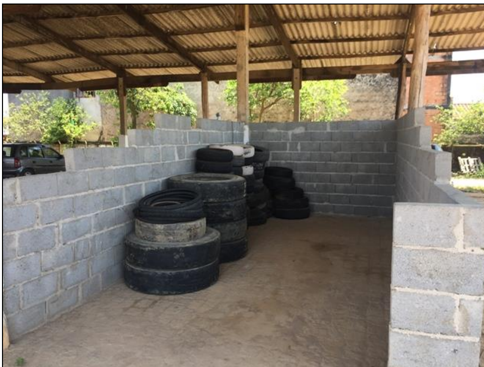
Figura 75 – Pátio da Subprefeitura Leste (PEV de pneus) Fonte: Premier Engenharia, 2019.
