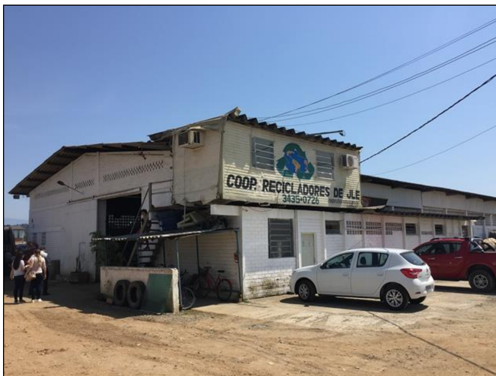
Figura 30 – Unidade de Reciclagem Santos Dumont – Coop. dos Recicladores de Joinville Fonte: Premier Engenharia, 2019.
