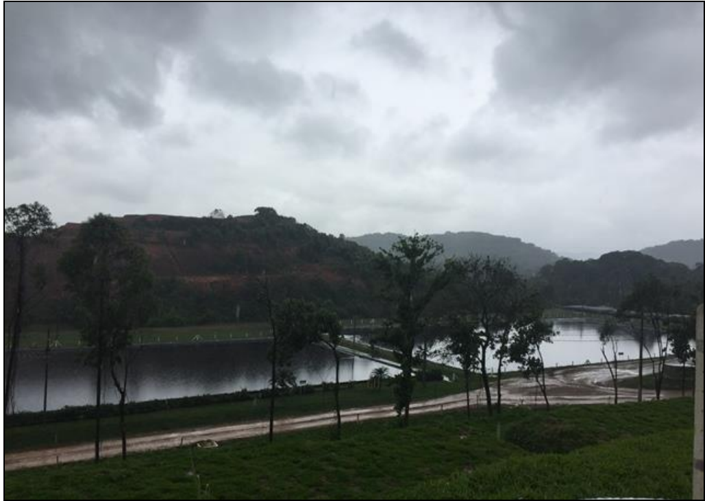
Figura 59 – Aterro sanitário municipal (estação de tratamento do chorume) Fonte: Premier Engenharia, 2019.
