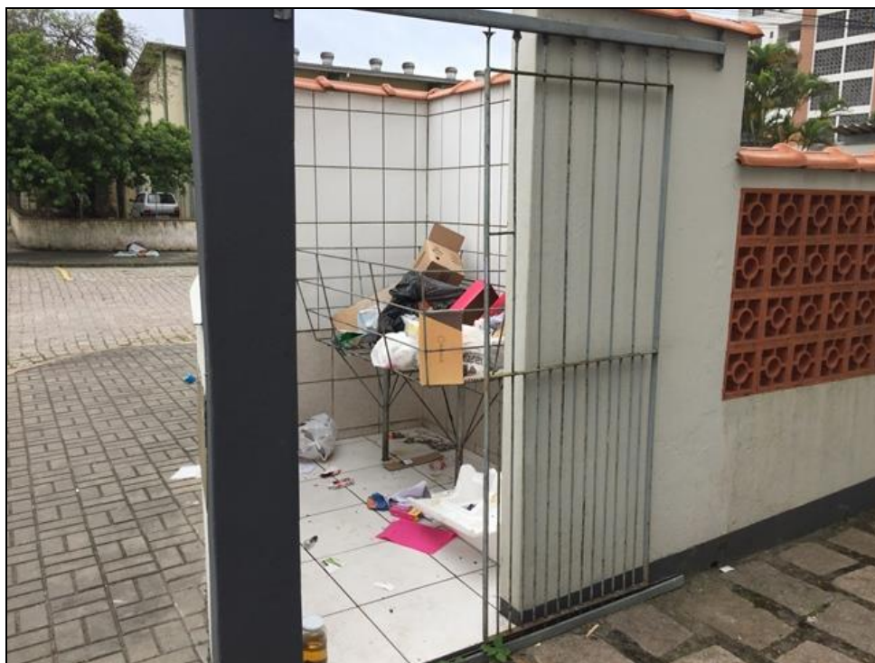
Figura 23 – Sacos dispostos em lixeira Fonte: Premier Engenharia, 2019.
