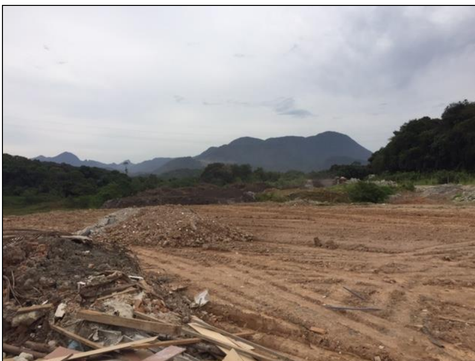
Figura 44 – Aterro de RCC da Empresa Terraplanagem Medeiros Fonte: Premier Engenharia, 2019.
