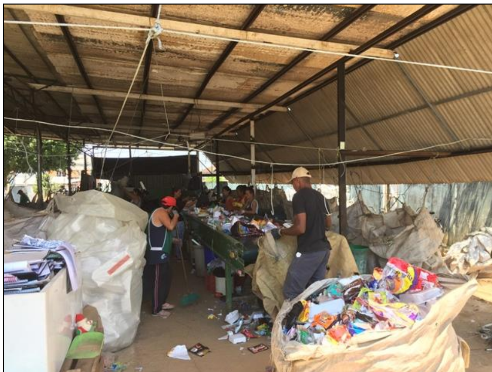
Figura 69 – Unidade de Reciclagem da ASSECREJO (esteira) Fonte: Premier Engenharia, 2019.
