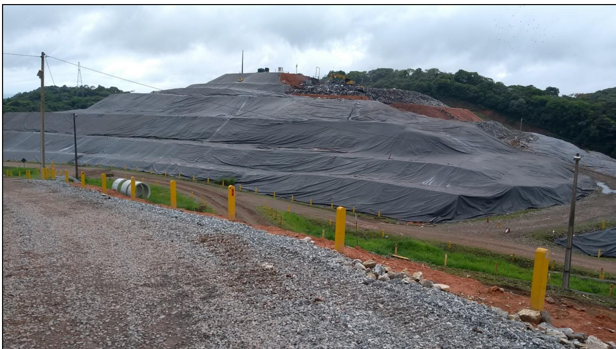
Figura 55 – Célula de disposição de resíduos classe II (aterro industrial da Essencis)
