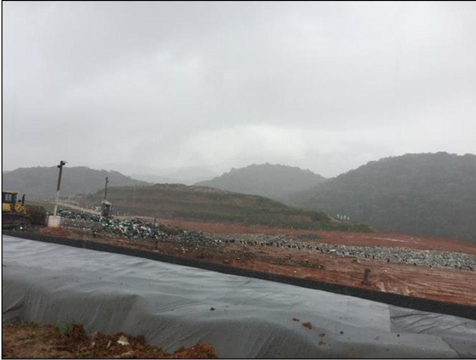
Figura 39 – Atual frente de serviço do aterro sanitário municipal Fonte: Premier Engenharia, 2019.
